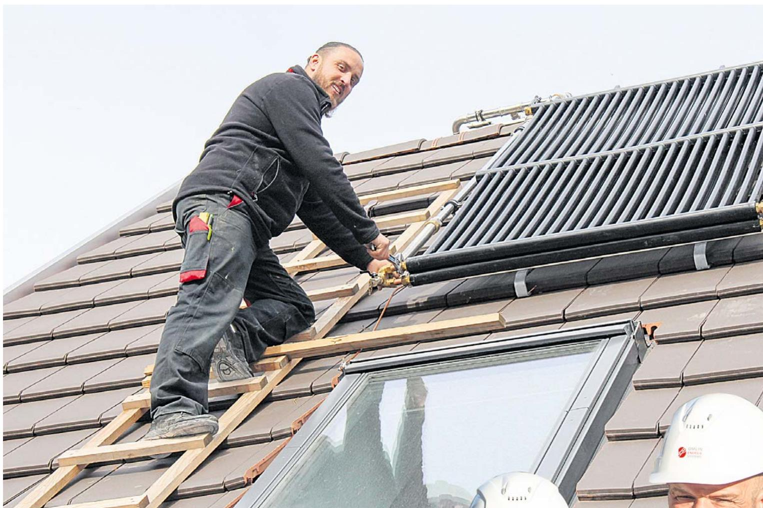
Ein Heizungsinstallateur der Omlin Energiesysteme AG zieht auf dem Dach die letzten Schrauben für die Wärmeabsorber an.
