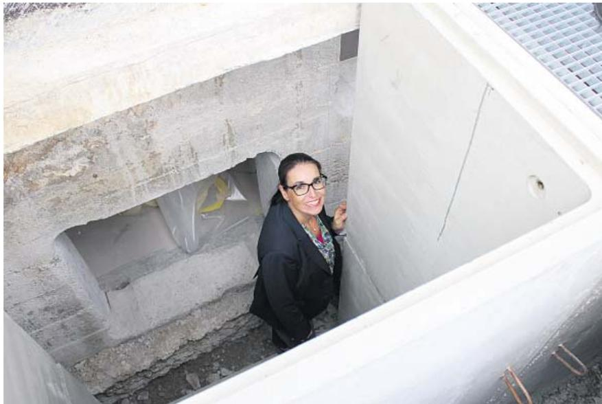
**Cornelia Omlin kontrolliert die drei Meter tiefen Schächte für die Kanäle der Luft-/Wasser-Wärmepumpe.**
