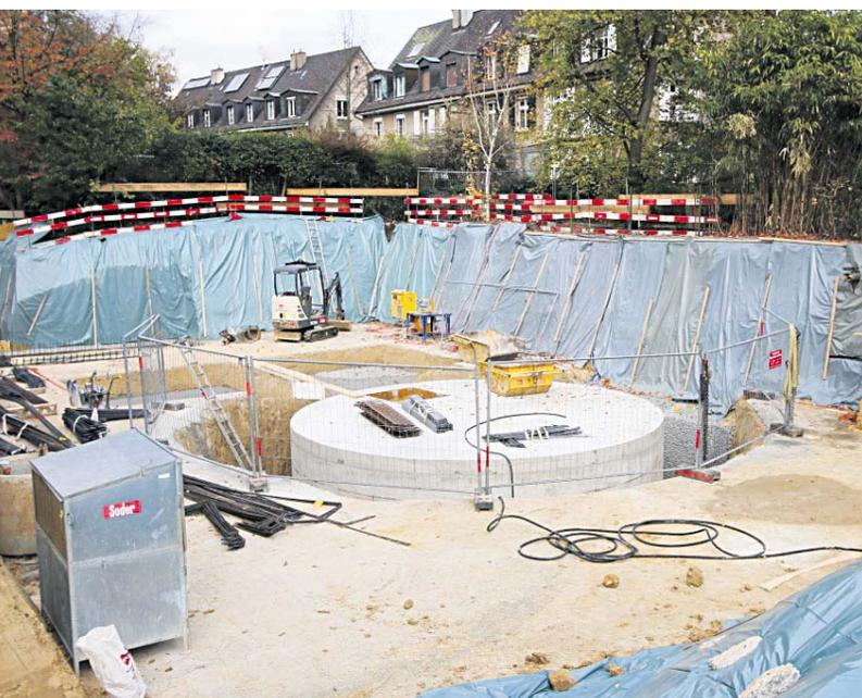
Der Wassertank für die Eisspeicherheizung wurde im Boden unter der Tiefgarage versenkt.
